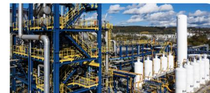
Air Liquide a mis au point un procédé unique au monde, la technologie **Cryocap™ H<sub>2</sub>**, mise en service en 2015 dans la plus grande unité de production d'hydrogène d'Air Liquide en France, à Port-Jérôme-sur-Seine. Cette technologie permet de récupérer et d'isoler le CO<sub>2</sub> émis lors de la production d'hydrogène grâce à un procédé « cryogénique ». Ce CO<sub>2</sub> certifié de qualité alimentaire est ensuite stocké sous forme liquide
